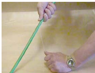
Skalning av kabel med hjälp av rivtråd
